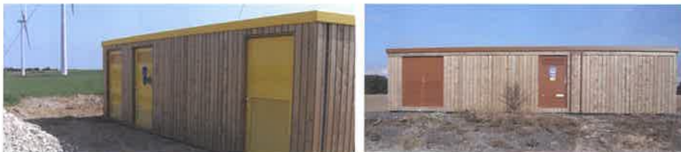
Illustration de postes de livraison avec un bardage bois
